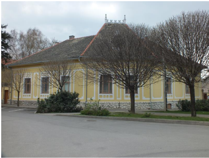
Uradalmi épület, udvarában két melléképülettel Szabadság u. 2.
