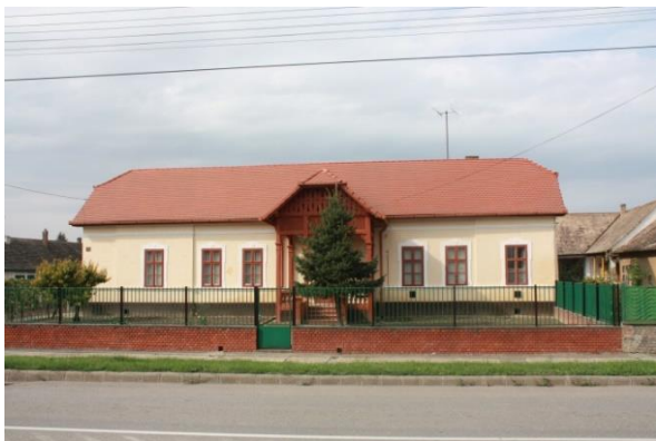
Lakóépület komplex felújítása (tető, homlokzat, nyílászárók).
