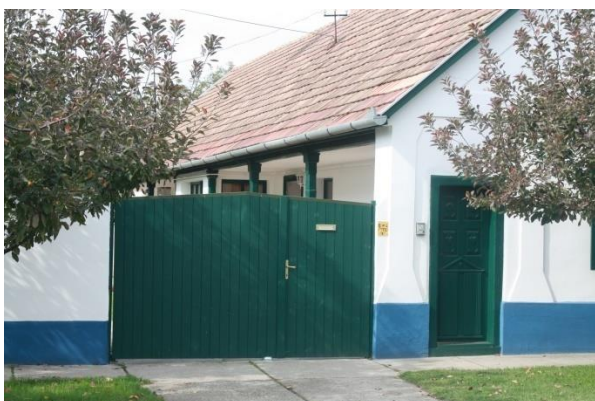
Lakóépület jókarban tartására példa. Eredeti állapotában őrzik az épület homlokzatát, nyílászáróit, kerítését, fedését. A színválasztás a lábazati kék szín vonatkozásában nem szokványos, de az összbenyomás megnyerő.
