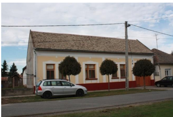
Lakóépület komplex felújítása (homlokzat, nyílászárók), jó színválasztással.
