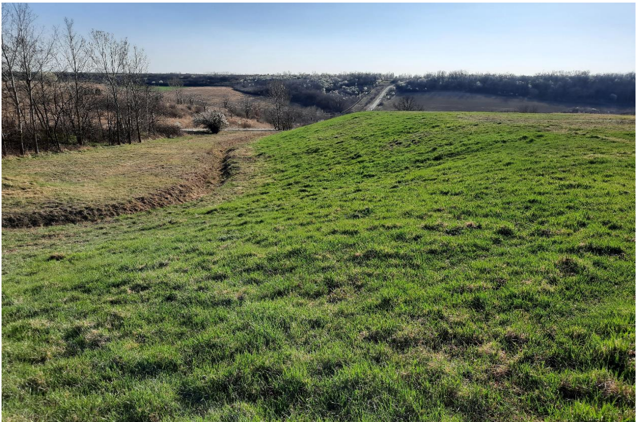
4. ábra: A lerakó állapota az 1. ütem lezárását követően
